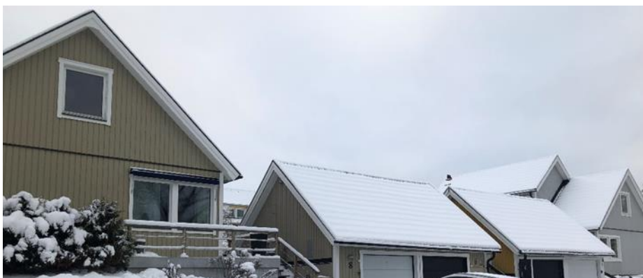
Figur 6: Byggnader i närheten av Husmodern 6.
